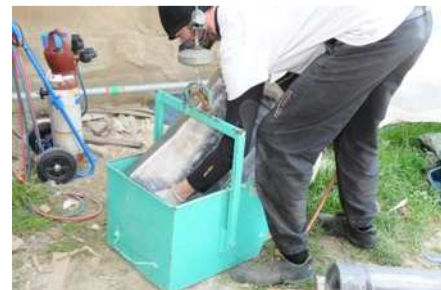
la plaque préparée est remontée
