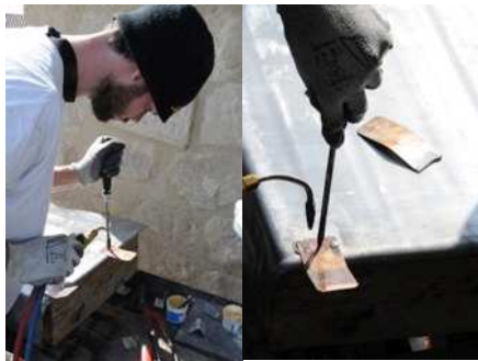
soudure des pattes de fixation
